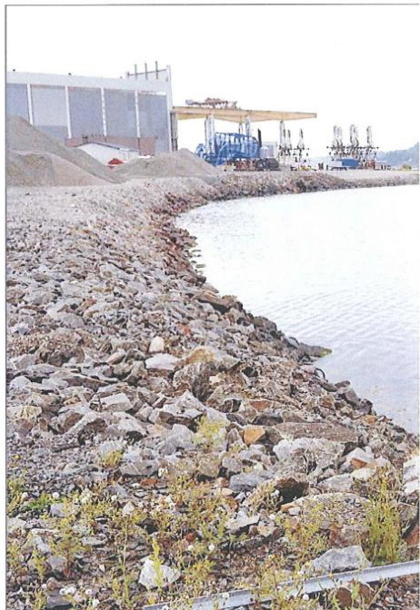
KOSTBAR OPPRYDDING: Ordfører Einar Halvorsen er et rent Tromsøysund i bakgrunnen. Til 1975, drev sin storforsurensning. Nå er de giftige avfallsmassene som inneholder tungmetaller og
